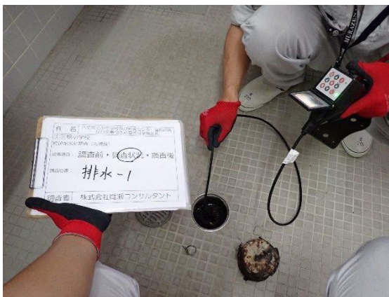
排水管内視鏡調査状況
