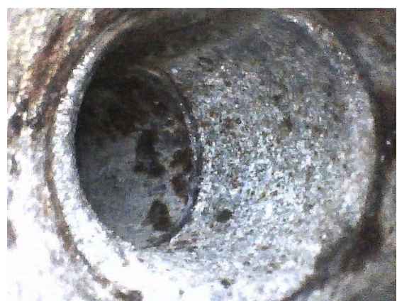
排水管内視鏡調査状況
