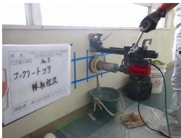
図 29：コア抜き状況
