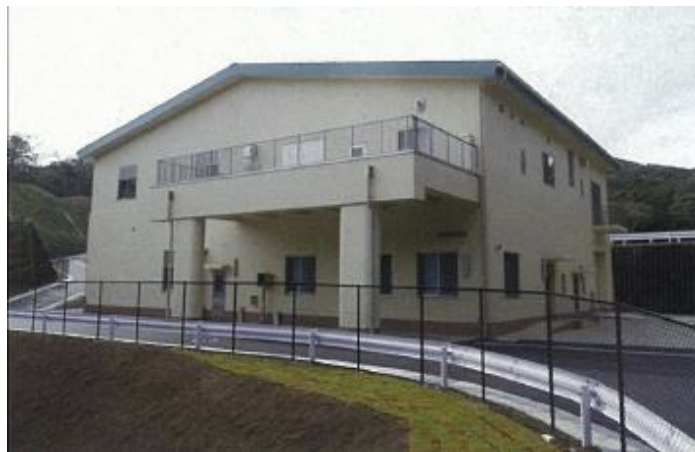
浸出水処理施設
