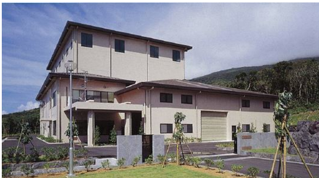
八丈町クリーンセンター
