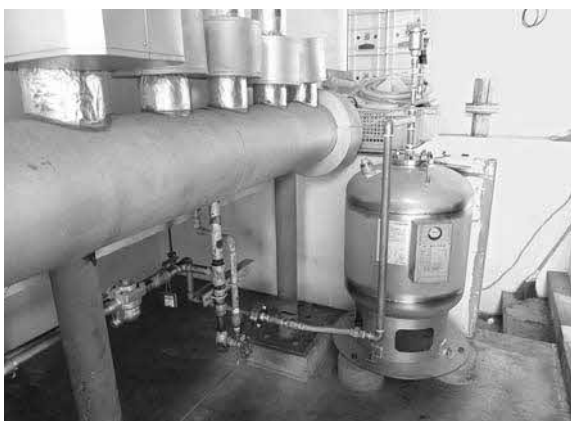
ポイラー工事修繕対象 膨張タンク
