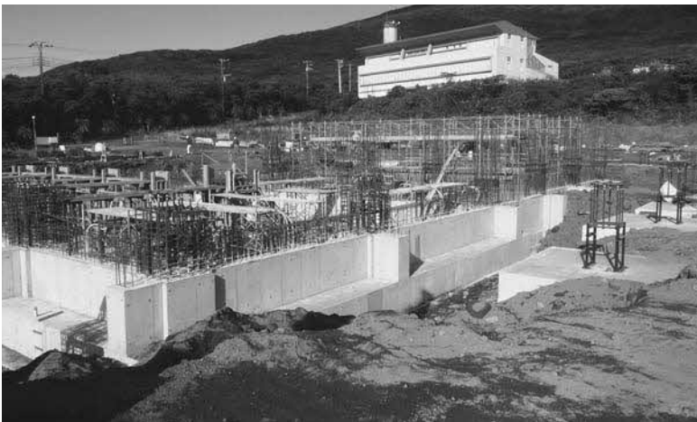
工事中の新クリーンセンター
