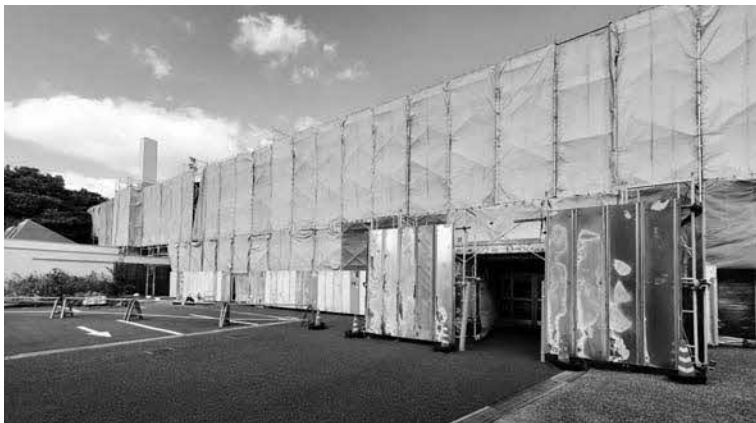
コミュニティセンターA棟防水改修工事（令和4年12月撮影）
