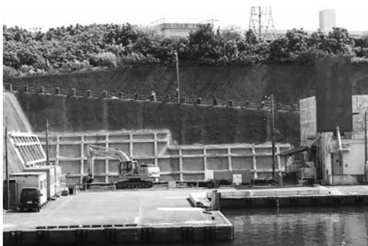
製氷施設建設中の神湊漁港内
