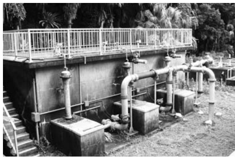
昭和52年築造。耐震性が低い大川浄水場
