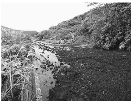
八丈富士登山道入口付近での土砂崩れ現場
