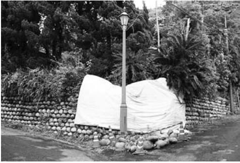
修復予定のシートに被われた玉石垣
