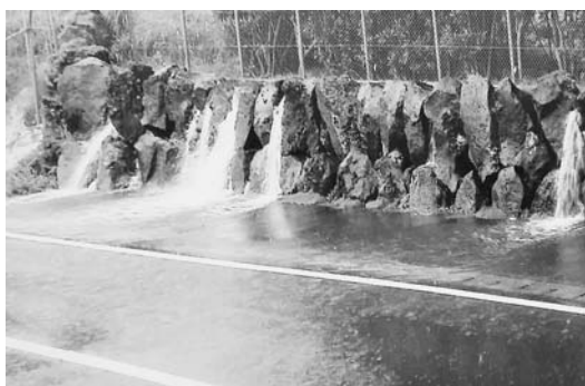
空港滑走路のり面
