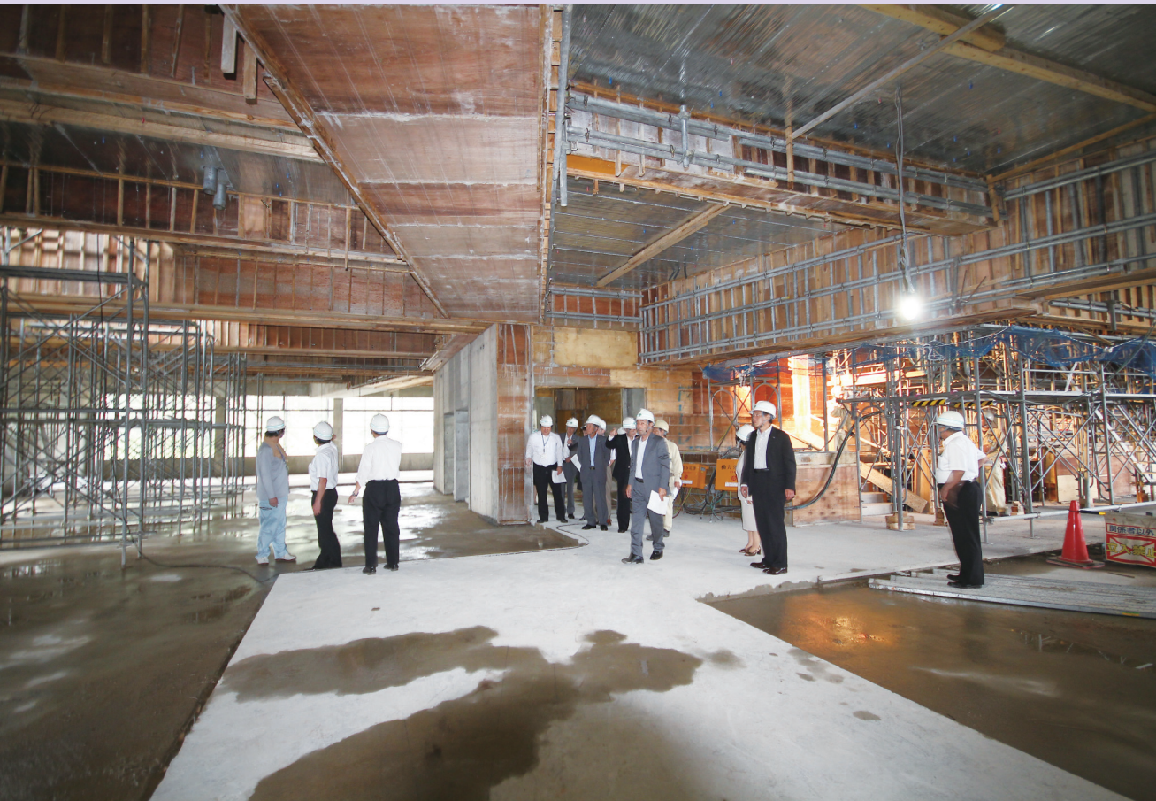
建設中の町役場新庁舎
