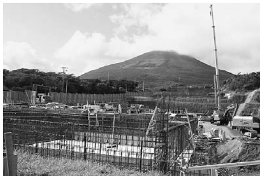
新庁舎建設の様子
