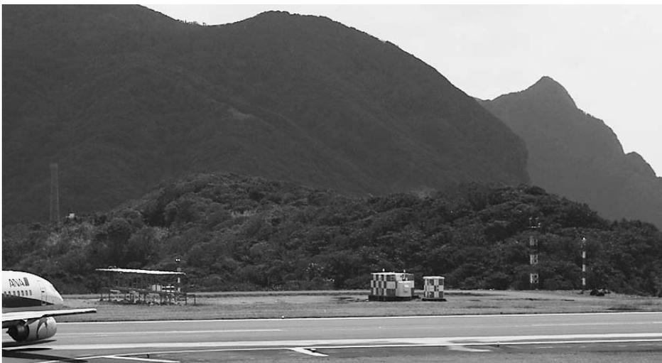
八丈島空港のILSは航空機に滑走路への進入方向を指示する装置で方位を示すLLZと、距離を示すターミナルDMEなどで構成されている
