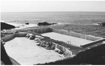
修繕後の乙千代ヶ浜プール
