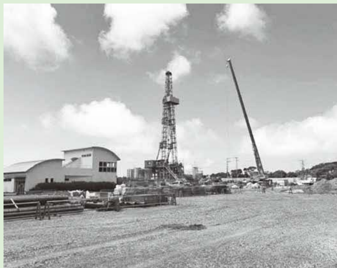
掘削機（やぐら）を使った地熱井掘削の様子
