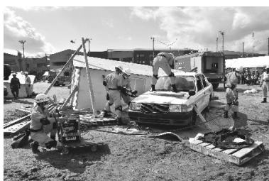
倒壊家屋からの救出・救助訓練
