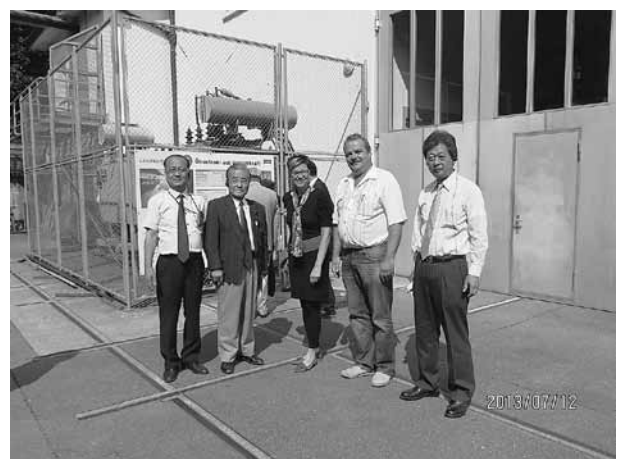
スイス「小水力発電施設」
