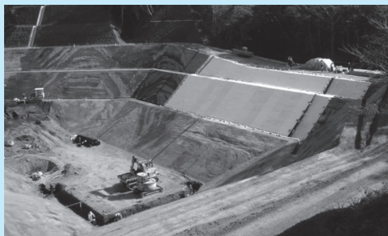
図 遮水工＜保護マット敷設状況(H24.3.29撮影)＞
