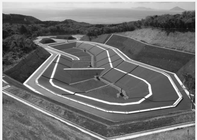
大島一般廃棄物管理型最終処分場 全景
