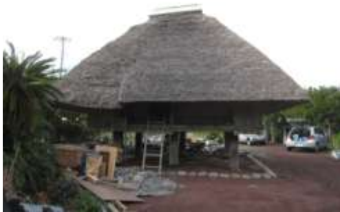
解体前の屋根の状況
