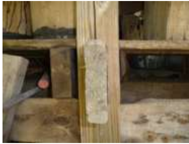
床組仕口によるエンノマ柱の支え (No. 25)
