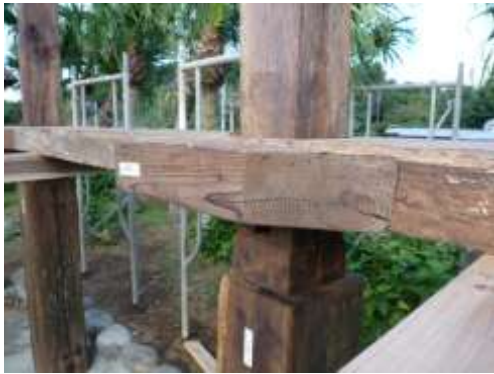
床桁取付完了
