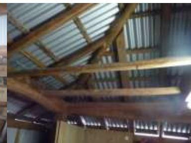
桁、梁と天井根太 (No. 7)
