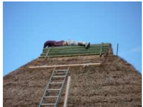
⑳棟仕上げ ツベ（竹簀巻き）を被せる
