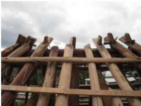
垂木先の仕口（平側より）
