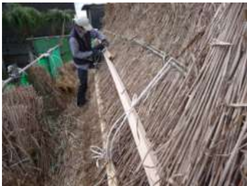
⑮平葺 足場仮設
