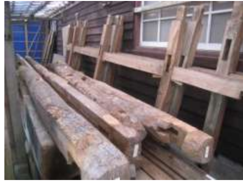
部材保管状況
