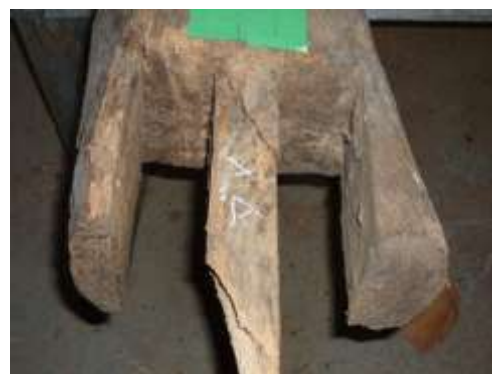
折損した床梁の仕口
