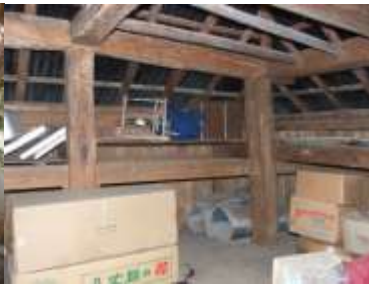
通し柱の貫 (No. 11)
