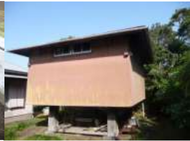
脚固めと床下収納 (No. 1)
