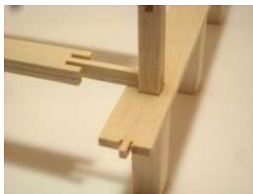
4 : 床桁・床梁の仕口
