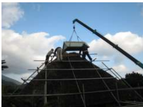
既存棟の解体
