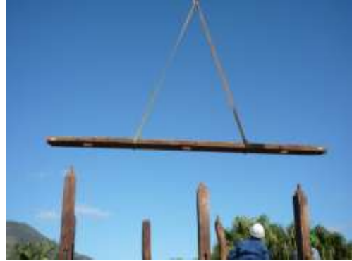
床桁の柱への差込
