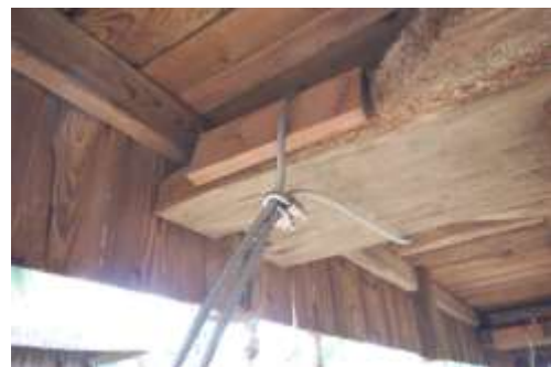
SUS製ワイヤ設置（転倒防止仮設材）
