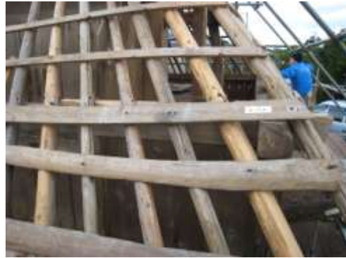
小舞板の取付状況
