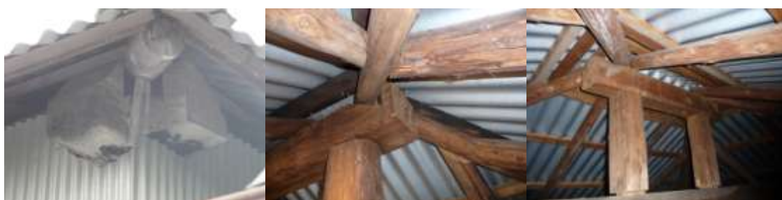
桁、梁に隅木架け痕 (No. 18)
