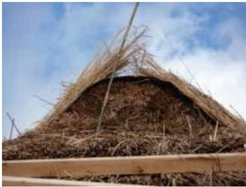
棟仕上げ 01 (ルーフィング敷込)
