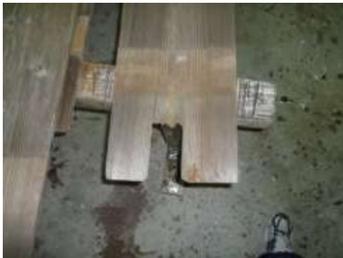
破損した外壁板
