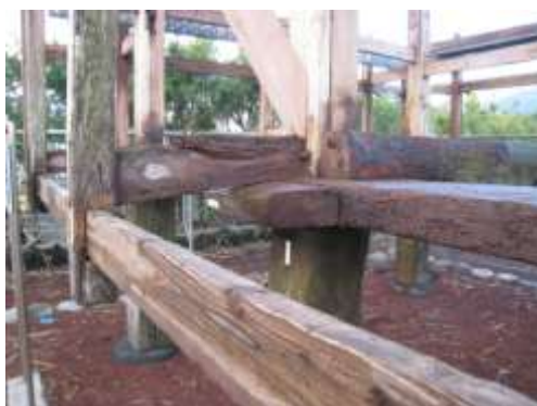
折損した床梁の鼻先
