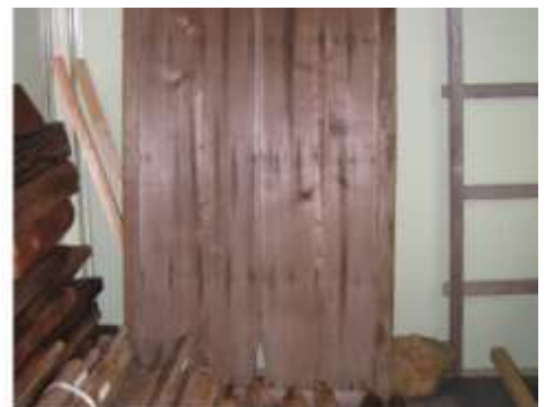
引戸の面板の割損
