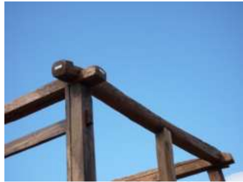
敷桁取付完了
