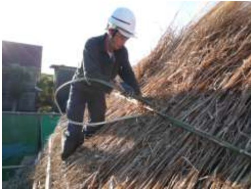
屋根 押鉾竹の固定
