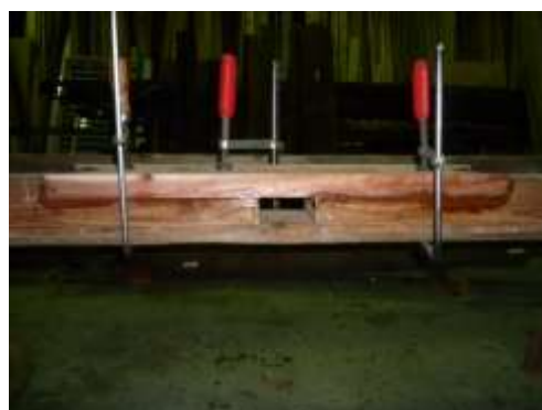
縁側柱の繕い 02
