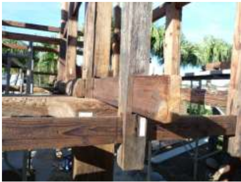
縁側柱の取付
