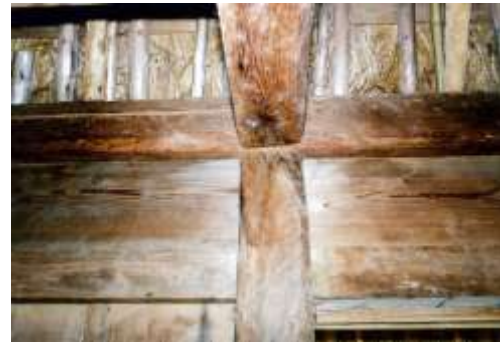
桁側面に残る板決り
