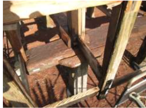
縁側柱を支える床梁と床桁
