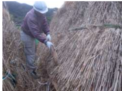
⑥平葺 ハゴイタによる整形
