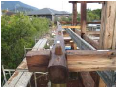
亀裂が入り歪んだ梁
