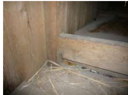
床板の割損（内部）
