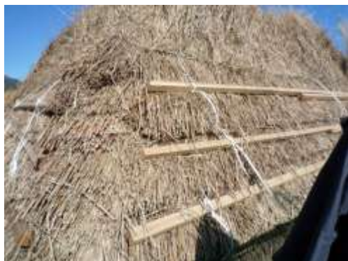
屋根 足場架設
