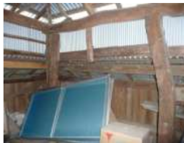
通し柱、桁、梁 (No. 18)
