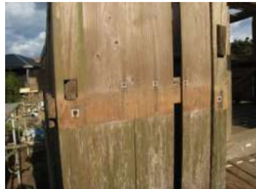
外壁に残る和釘の痕跡
