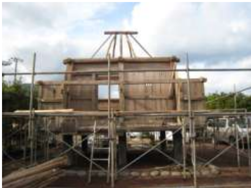
垂木解体完了
