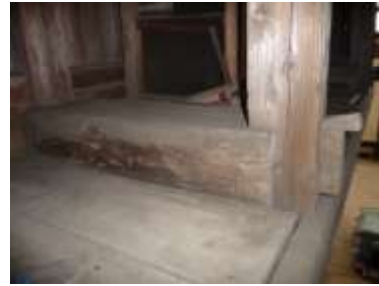
床組仕口によるエンノマ柱の支え (No. 3)
