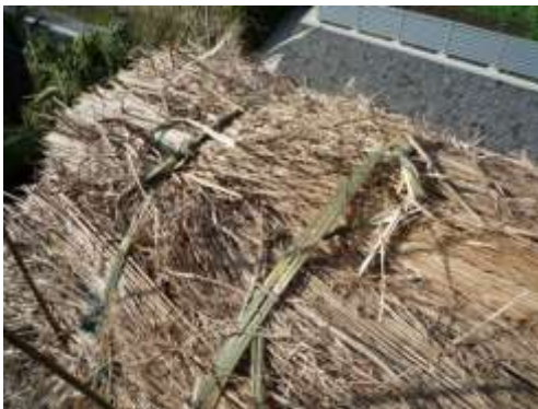
⑲棟仕上げ ハリダケによる固定
