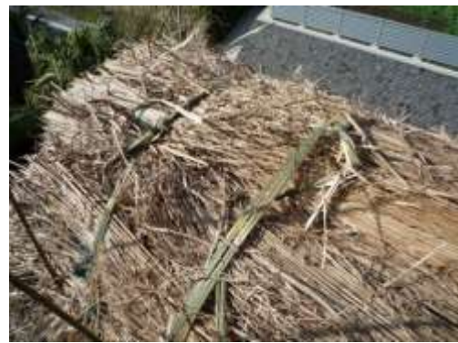
棟仕上げ 02 (ハリダケによる固定)
