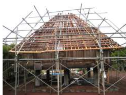
垂木の垂下と小舞板の破損
