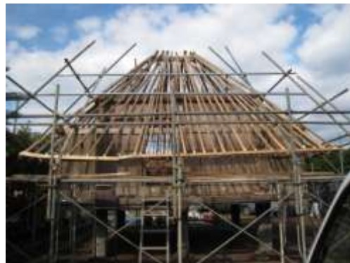
小舞解体完了
