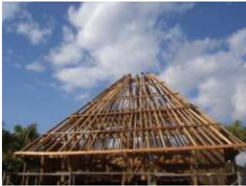
小舞板の取付
