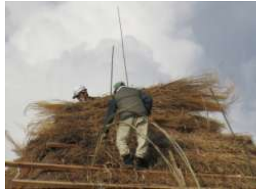
⑩棟仕上げ 茅の積み上げ
