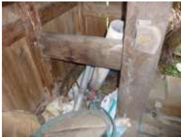
通し柱とエンノマ柱の貫 (No. 21)
