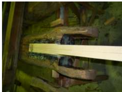
床梁繕い完了
