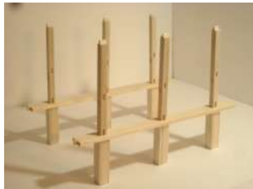
2 : 柱に床桁を通す
