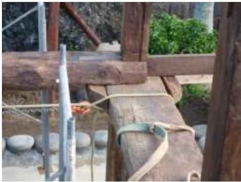
床梁取付完了
