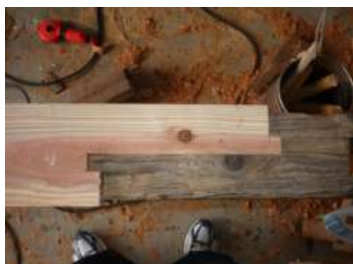
縁側柱の繕い 01
