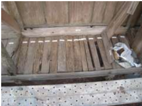
床板の破損（縁側）
