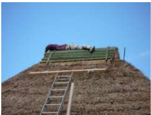
棟仕上げ 03 (ツバー竹簾巻)
