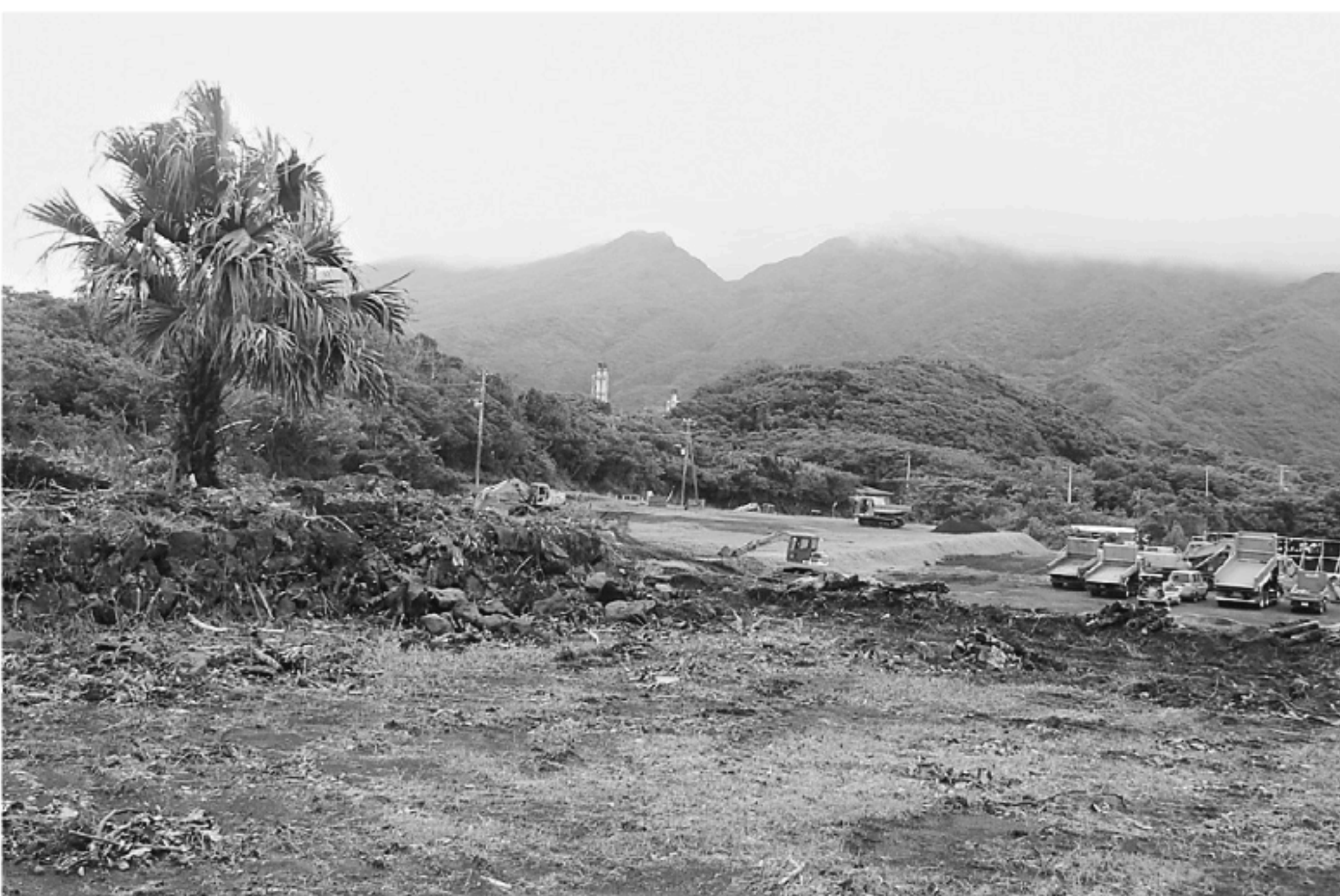
現在造成中の役場新庁舎建設予定地
