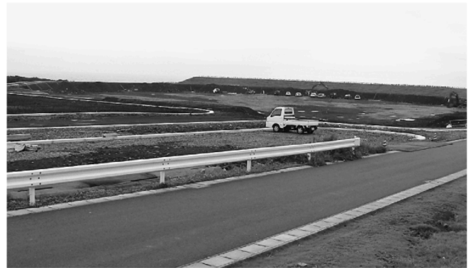
造成中の南原スポーツ公園野球場
