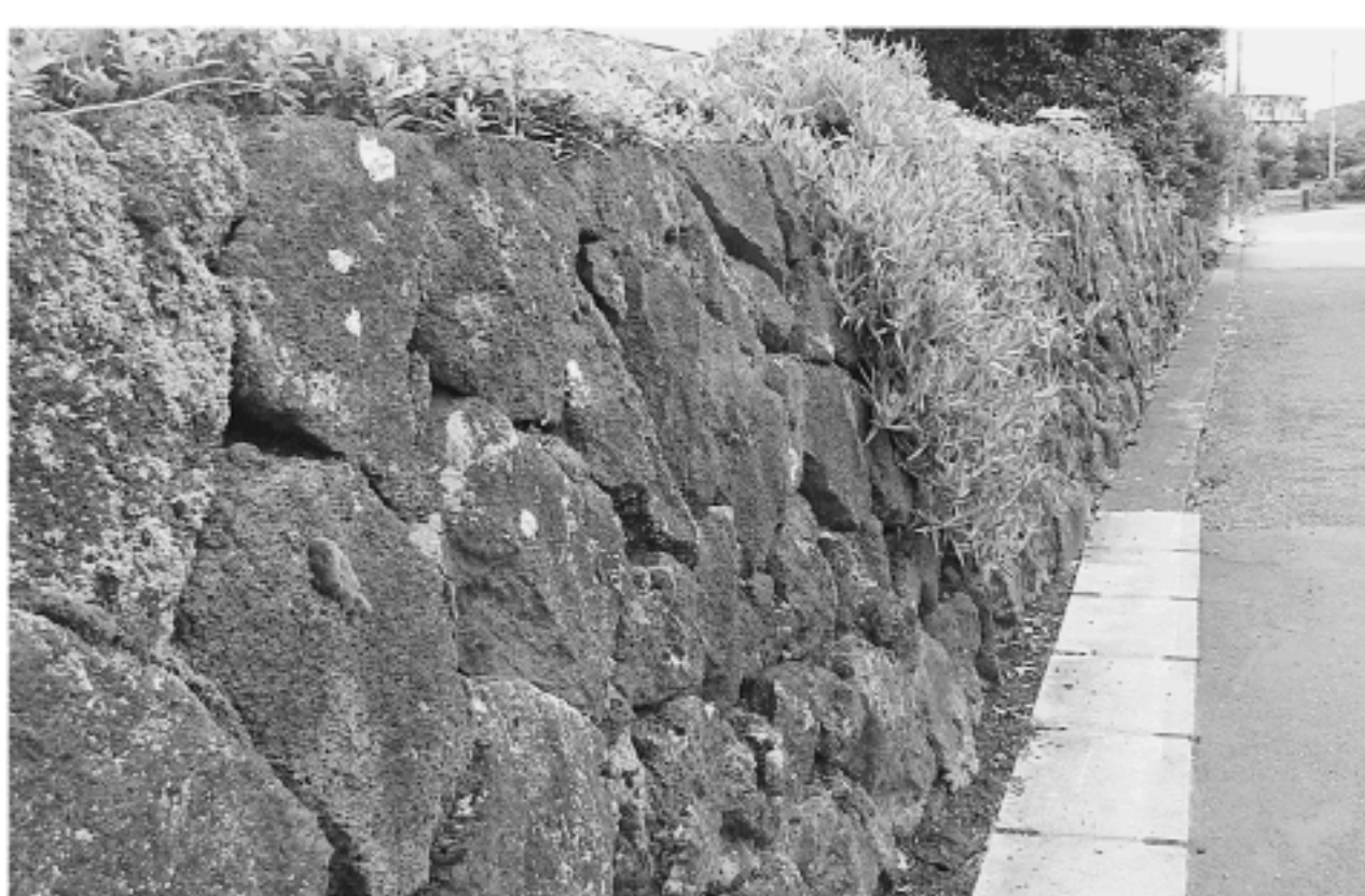
自然石を使用した石垣
